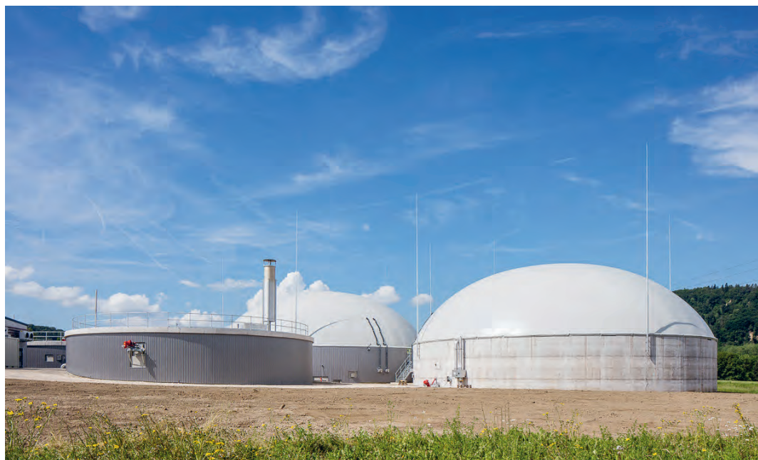
Construite et exploitée par Groupe E Greenwatt, la centrale à biogaz d'Henniez est la plus grande installation du genre en Suisse.
